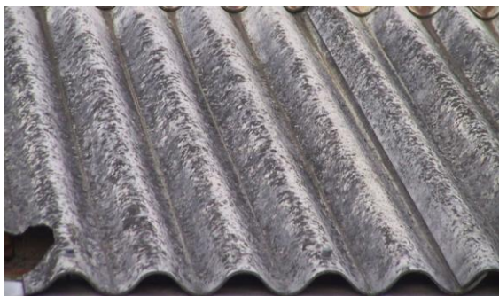
copertura in cemento-amianto
